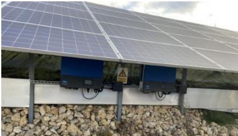
*Abbildung 5, Beispiel Montageposition Wechselrichter*
